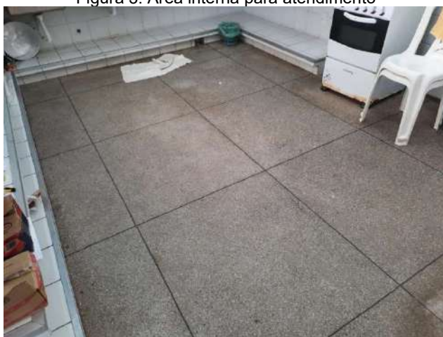
Figura 5. Piso da parte interna da cantina
