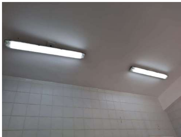
Figura 7. Luminárias da parte interna da cantina
