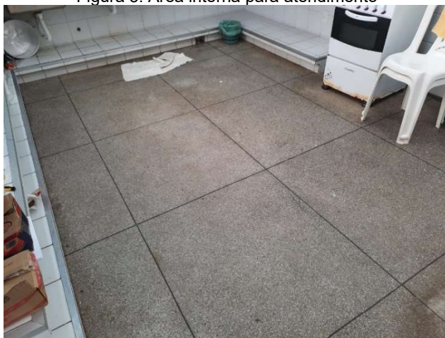
Figura 5. Piso da parte interna da cantina
