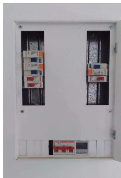
**Figura 11. Quadro de energia com medidor digital**
